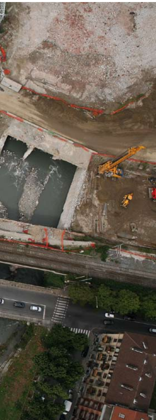
Figura 1 - Area di cantiere a ridosso della Dora Riparia
