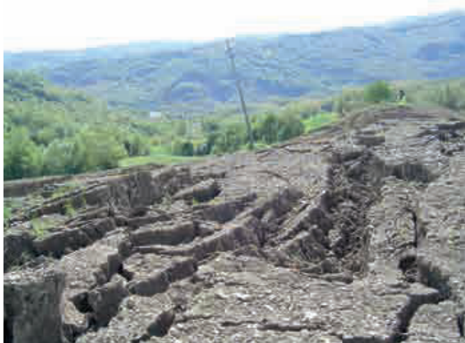
Foto 3 – Sauna (Comune di Corniglio): vista delle fratture e delle contropendenze del piede della frana. Si noti l'assenza di copertura agronomica e di scoline (maggio 2013, foto Pelosio).
