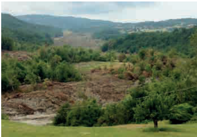
Foto 13b - Località Ponte Antria (Comune di Tizzano V.P.): vista dal ponte sulla S.P. 665R Massese del piede e del corpo di frana in avanzamento (giugno 2013, foto Ruffini).
