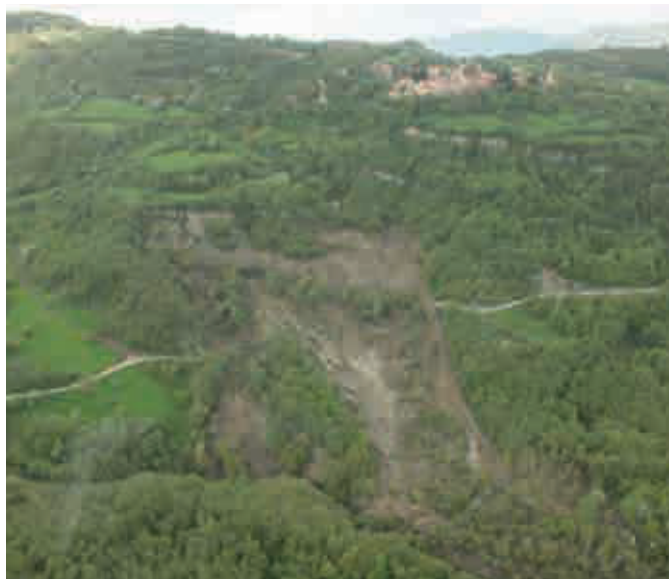
Foto 1b – S.P. 65, località Musiara Inferiore (Comune di Tizzano Val Parma): il dissesto ha completamente interrotto la viabilità provinciale per Schia (maggio 2013, foto Castagnetti).
