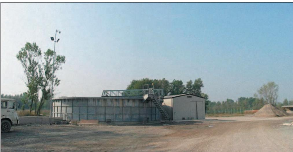
Foto 2 - Ripresa fotografica di un chiariflocculatore al servizio di un impianto di lavorazione inerti.
