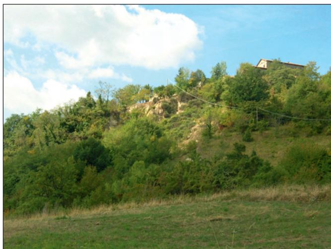
Figura 10: Dettaglio della scarpata della frana di Ribecco. Da notare i prismi rocciosi distaccati lungo superfici sub-verticali.
