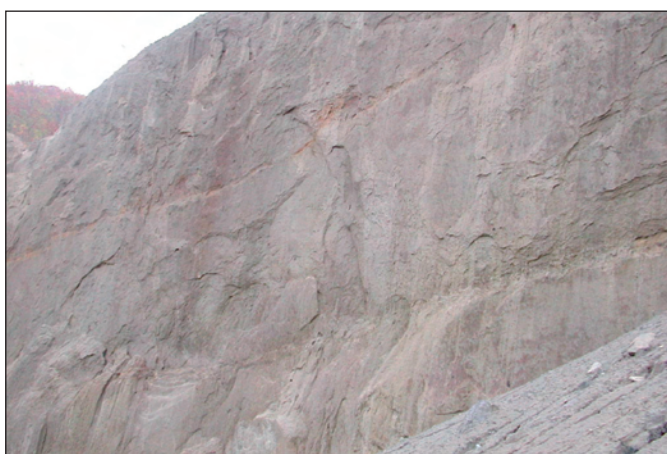
Foto 5: Fronte subverticale - lo scavo ha assecondato l'assetto di un giunto strutturale.
