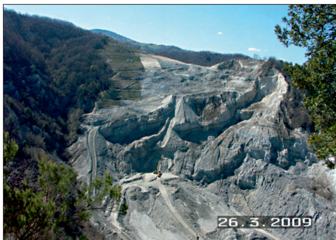
Foto 9: Panoramica del fronte di scavo e dell'aia di carico (mar 2009).
