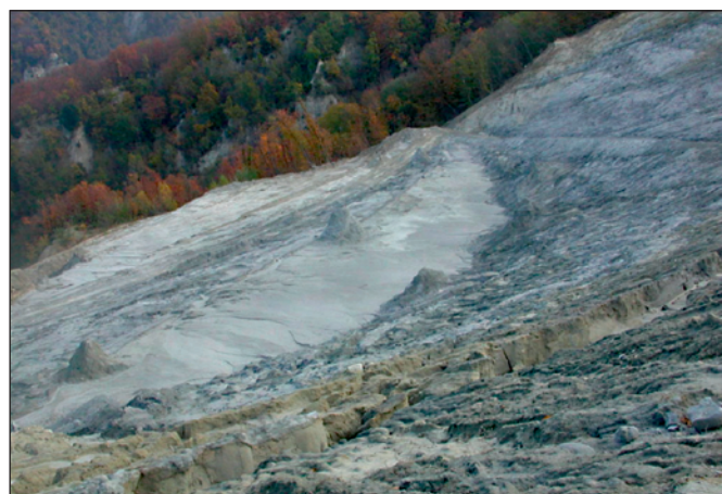
Foto 3: Sistema di giunti strutturali ad andamento subverticale - il fronte di scavo ha una geometria condizionata (detensionamento).
