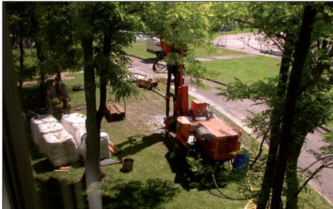
Fig. 5: cantiere di realizzazione di sonde geotermiche verticali
