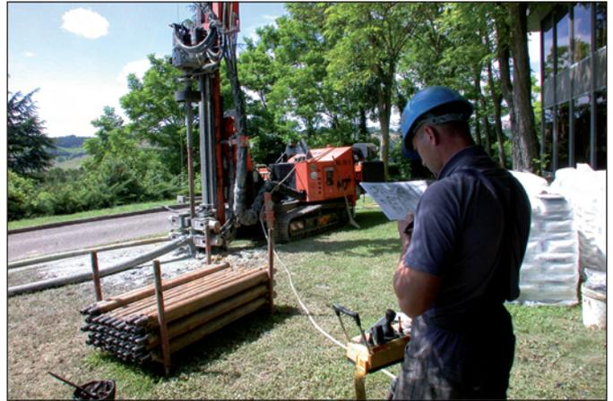
Fig. 6: perforazione di sonde geotermiche verticali
