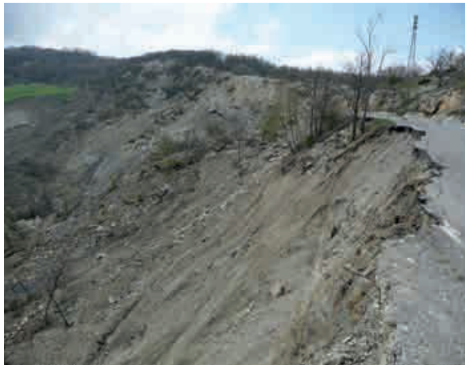
Figura 6 – Zona di distacco del corpo settentrionale della frana di Pianestolla, riattivato assieme a quello meridionale di Capriglio (sullo sfondo) dall'evento meteorico di marzo-aprile scorso (Comune di Tizzano Val Parma).
