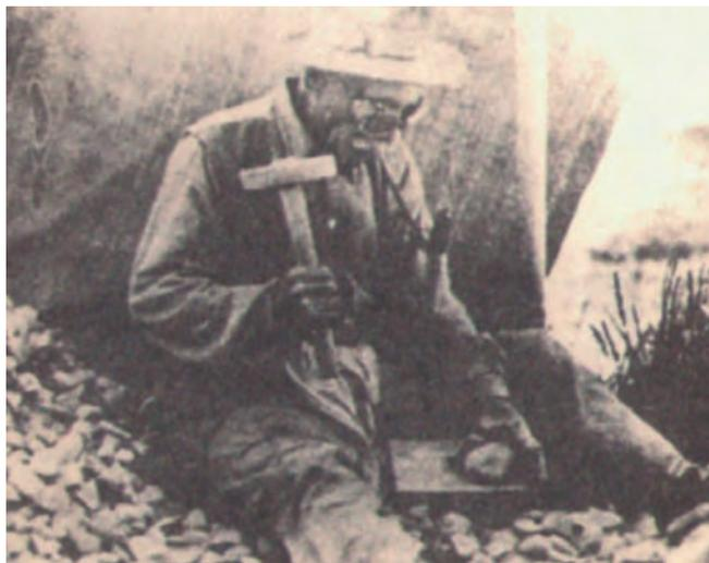
FIGURA 4: un macarè intento a spaccare i sassi, usati per l'inghiaiatura delle strade
