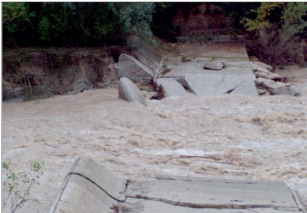
Foto 1 - Rottura della briglia di Ponte Verucchio, dopo la piena dell'ottobre 2005 del F. Marecchia - (Foto C. Guerra)
