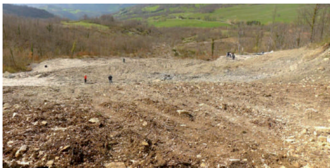
FIGURA 14 - Vista della frana dal coronamento: la sede stradale è stata completamente asportata dal movimento
