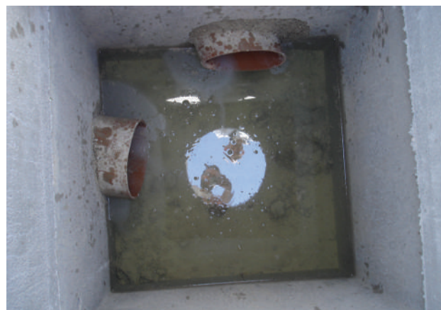
FOTO 6 - Il dettaglio di uno dei pozzetti di raccordo tra trincee e collettore di base mette in evidenza la funzionalità del sistema drenante già attivo durante le fasi di posa
