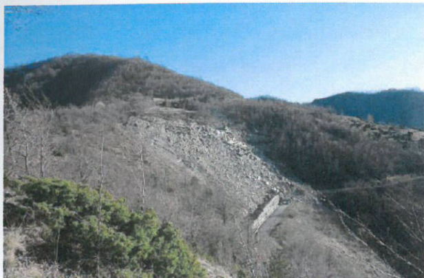
FIGURA 50 - immagine panoramica della frana sulla SP 25 (foto gentilmente concessa dal Dr. Geol. Alessandro Stefani)
