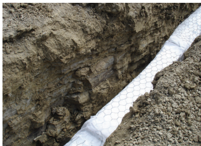
FOTO 3 - Linea drenante in trincea con evidenza delle litologie di copertura e delle loro caratteristiche litologiche e tessiturali
