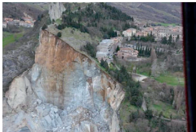
FIGURA 44 - Immagine della parete franata e degli edifici sgomberati. (foto gentilmente concessa dal Servizio Tecnico di Bacino della Romagna)
