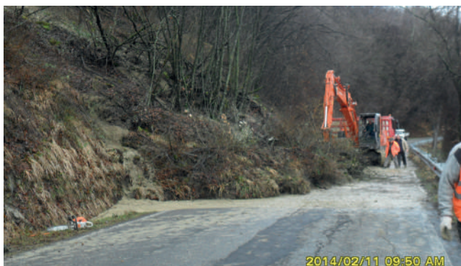
FIGURA 8 – Situazione di tipo b) in località l'Angela, SP 80 di Scurano, in Comune di Neviano degli Arduini (PR), con interruzione completa (anche se temporanea) del transito per invasione di terra e detrito (foto gentilmente concessa dalla Provincia di Parma)
