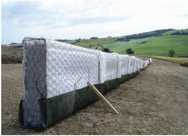
FOTO 1 - Fasi di montaggio di uno dei bracci della linea drenante. Si noti la guaina impermeabile al fondo del pannelli
