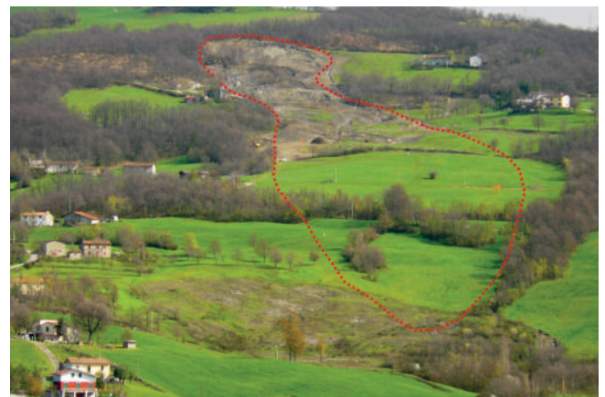
FIGURA 42 - Panoramica sul dissesto ripreso da SO, presso la località Cà Faziello. La zona riattivata è indicata dal tratteggio rosso
