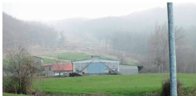
FIGURA 21 - Vista del piede della frana di Torre Chiastre; in primo piano l'omonima località, posta pochi metri a valle del piede della riattivazione
