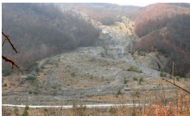
FIGURA 17 - Immagine del piede della frana di Sassi Neri. Si notano la strada comunale, l'acquedotto comunale, esposto in superficie per evitare lesioni dovute al movimento franoso e in alto a destra il ramo settentrionale della frana oggetto in passato di sistemazioni idrauliche superficiali
