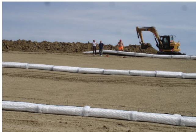
FOTO 5 - Vista del pendio da valle. Sono evidenti le linee drenanti parallele già montate e pronte alla posa in scavo
