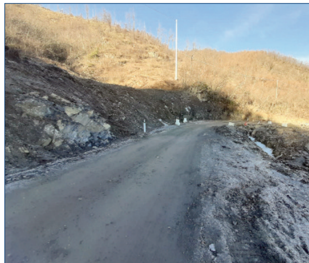
Figura 14. Rifacimento della S.P. n. 654R con intervento di rimozione parziale del deposito di frana nel tratto ricadente entro l'Unità B (intervento realizzato in somma urgenza nel dicembre 2019).
