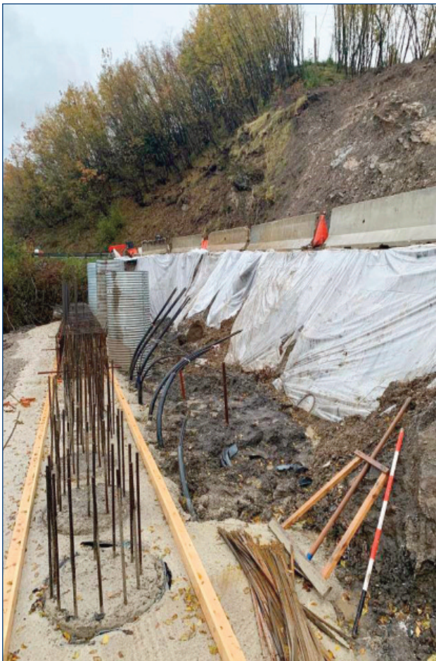
Figura 16. Pali, pozzi e tiranti durante le fasi di lavorazione di cantiere prima del getto della trave di testa. In alto a destra si notano le scarpate che saranno rimodellate a fine lavori ai fini di garantirne la stabilità.
