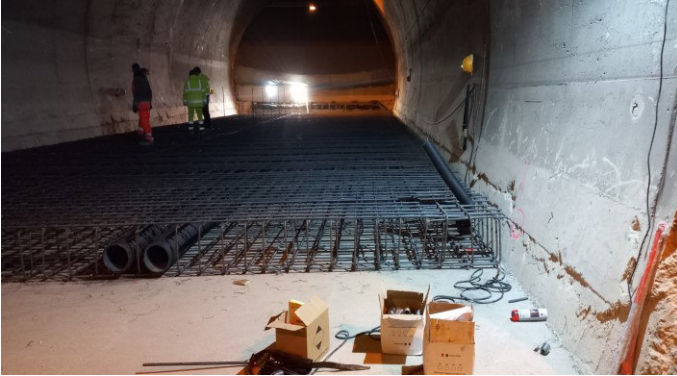
ARMATURA E GETTO FONDAZIONE BYPASS N. 2
