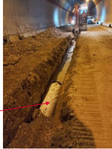
Tube di fondo phi 400 microfessurato con portata di 366 l/s
