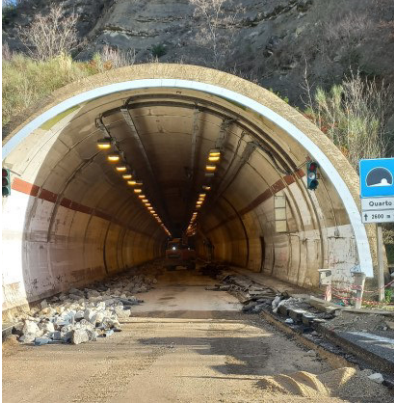
CANNA NORD DIREZIONE RAVENNA FRESATURA PAVIMENTAZIONE STRADALE
