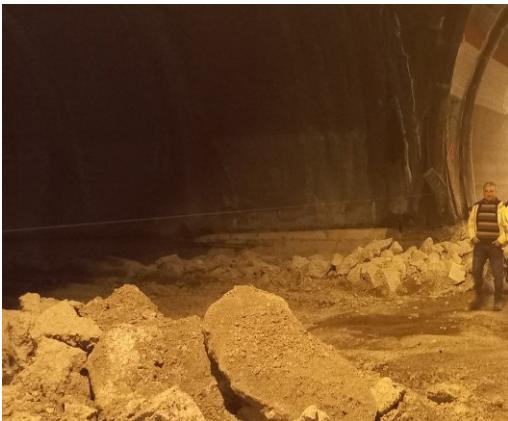
DEMOLIZIONE ED ABBASSAMENTO PAVIMENTAZIONE STRADALE BYPASS N. 2 E 4
