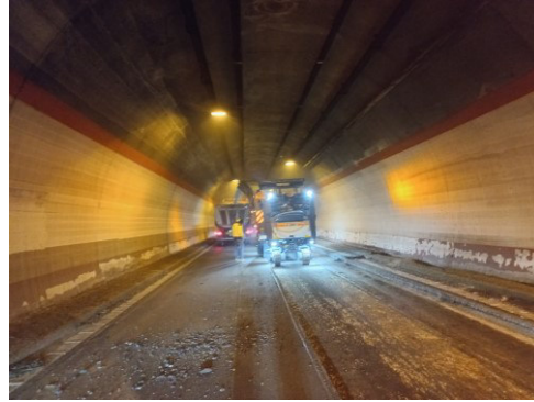
CANNA NORD DIREZIONE RAVENNA FRESATURA PAVIMENTAZIONE STRADALE
