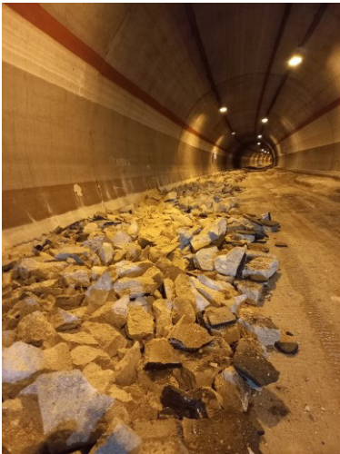
DEMOLIZIONE MARCIAPIEDI ED ABBASSAMENTO PAVIMENTAZIONE STRADALE
