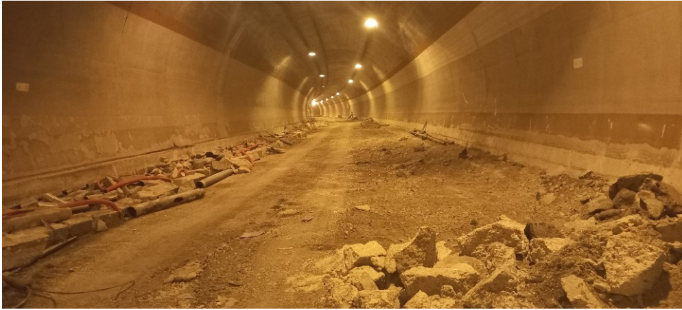
DEMOLIZIONE MARCIAPIEDE ED ABBASSAMENTO PAVIMENTAZIONE STRADALE
