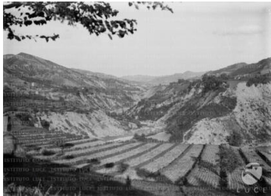
1928: sistemazione sponda sinistra (forse: manca ubicazione)
