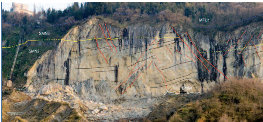
Figura 12. Parete NNW dopo il crollo del 2006. La stratificazione a banchi del membro SMN2 non è piano-parallela, s'immerge mediamente verso ENE e mostra variazioni di spessore che non si notavano nella parete NNE. Il contatto tra SMN2 e SMN3 è visibilmente discordante. Continua la gradinata di faglie distensive immergenti a WSW già vista nella parete NNE. Il membro MFU1 non affiora, anche perché la sommità della rupe è attualmente coperta dal bosco.
