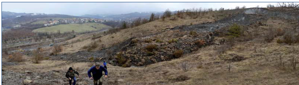
Figura 2. Frana per colamento avvenuta dopo le precipitazioni di inizio febbraio in comune di Gaggio Montano (BO), loc. Silla, e che ha coinvolto l'ex SS 64 Porrettana (foto del Servizio Area Reno - Regione Emilia-Romagna).
