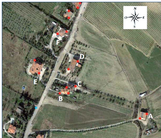
Figura 21. Monitoraggio topografico attraverso la collimazione di spigoli dei fabbricati indicati con punto rosso. Confronta con la Tab. 3.
