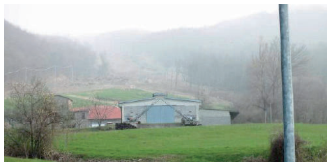
FIGURA 21 - Vista del piede della frana di Torre Chiastre; in primo piano l'omonima località, posta pochi metri a valle del piede della riattivazione
