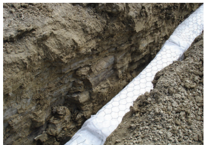
FOTO 3 - Linea drenante in trincea con evidenza delle litologie di copertura e delle loro caratteristiche litologiche e tessiturali
