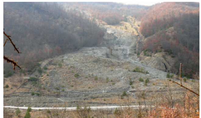
FIGURA 17 - Immagine del piede della frana di Sassi Neri. Si notano la strada comunale, l'acquedotto comunale, esposto in superficie per evitare lesioni dovute al movimento franoso e in alto a destra il ramo settentrionale della frana oggetto in passato di sistemazioni idrauliche superficiali
