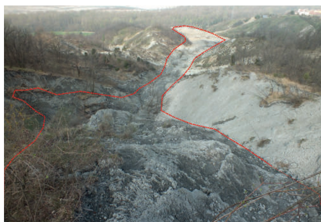
FIGURA 25 - Panoramica della frana dal coronamento
