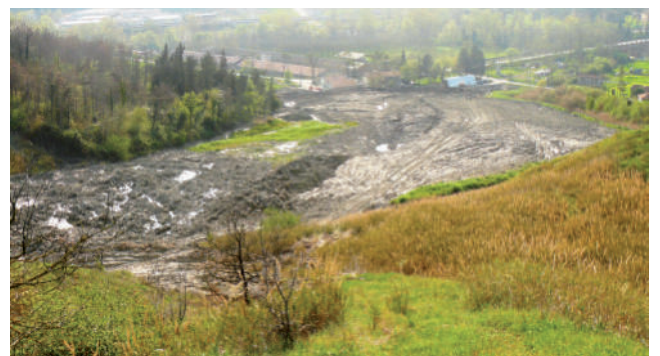
FIGURA 35 - Vista del piede della frana di Montevécchio
