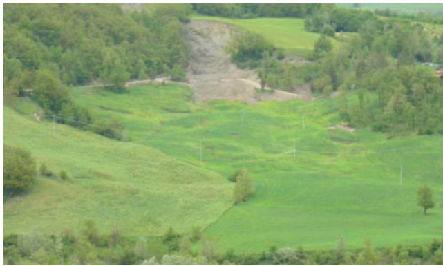
FIGURA 31 - Vista della frana di Quercioli. Nella parte alta è visibile il terreno interessato da colate, nella parte bassa le aree interessate da scorrimento. La SP visibile nella parte bassa (non indicata nella FIGURA35) è interessata da fratture trasversali
