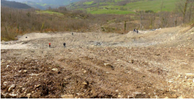
FIGURA 14 - Vista della frana dal coronamento: la sede stradale è stata completamente asportata dal movimento
