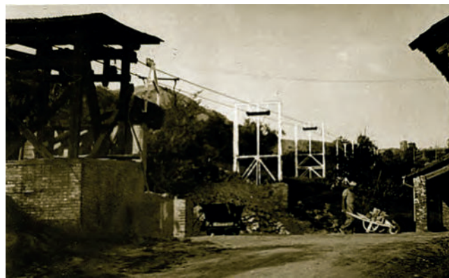
FIGURA 19: foto storica della teleferica per il trasporto dei blocchi di gesso dalla cava del Monticino al Mulino di cottura e lavorazione, detto "Molinone"
