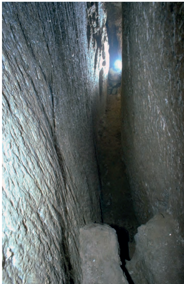
FIGURA 14: un cunicolo della Grotta della Lucerna, con scalpellature sulle pareti
