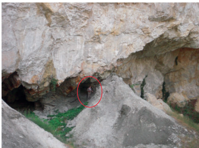
Fig. 7 - La parete nord della rupe di San Leo prima del crollo con alla base la marcata sotto-escavazione e fenomeni gravitativi (colate). La relativa foto di dettaglio fornisce un'idea delle dimensioni del fenomeno (come scala il Geol. M. Gabrielli).
