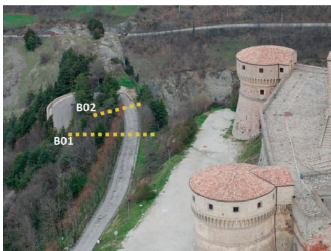
Fig. 27 - Traccia dei sondaggi sub-orizzontali attrezzati con estensimetri multibase in foro nella zona del tornante della strada di accesso alla fortezza.
