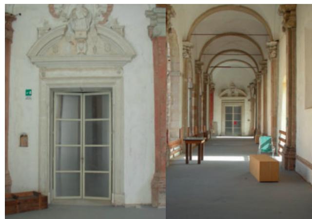
Fig. 17b – I corridoi e i locali interni
