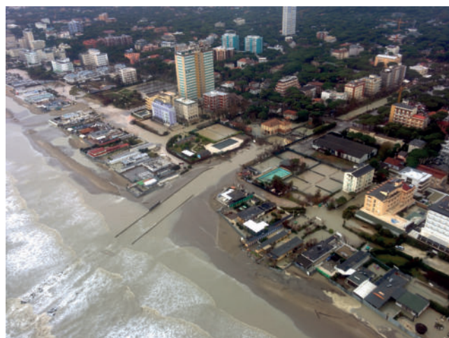
Fig. 5 - Inondazione dell'abitato di Cesenatico in occasione della mareggiata del 6 febbraio 2015.
