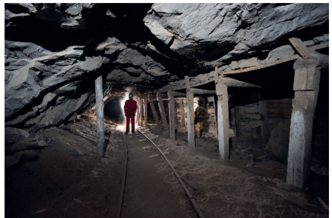
Fig. 8 – Livello 0, a destra l'area di manutenzione dei locomotori.
