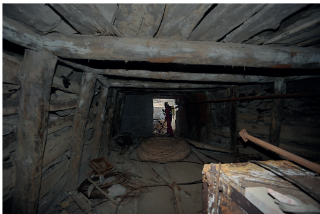
Fig. 9 – Giro Cavalli, sala dell'argano e accesso alla discenderia Ovest.
