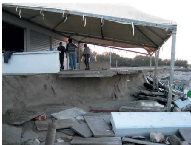
Fig. 4 - Esempio di grave erosione della spiaggia e danneggiamento delle infrastrutture turistiche.
