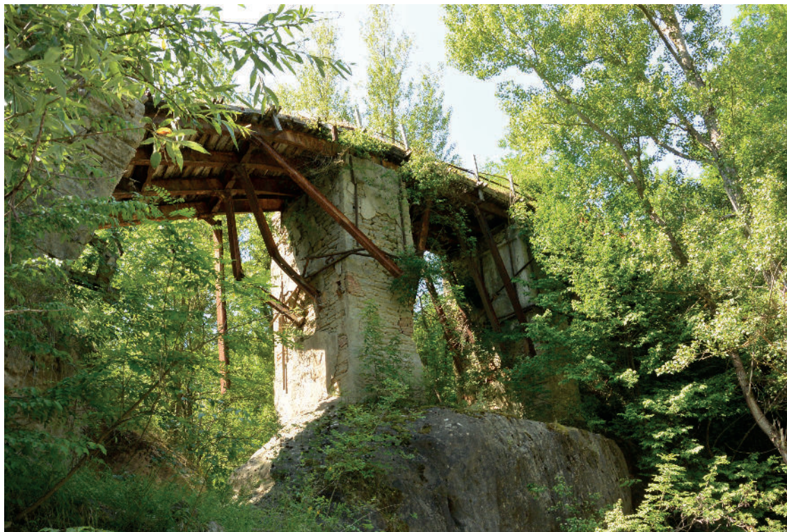
Fig. 4 – Il vecchio ponte sul Torrente Fanante, lungo la via alla miniera.
