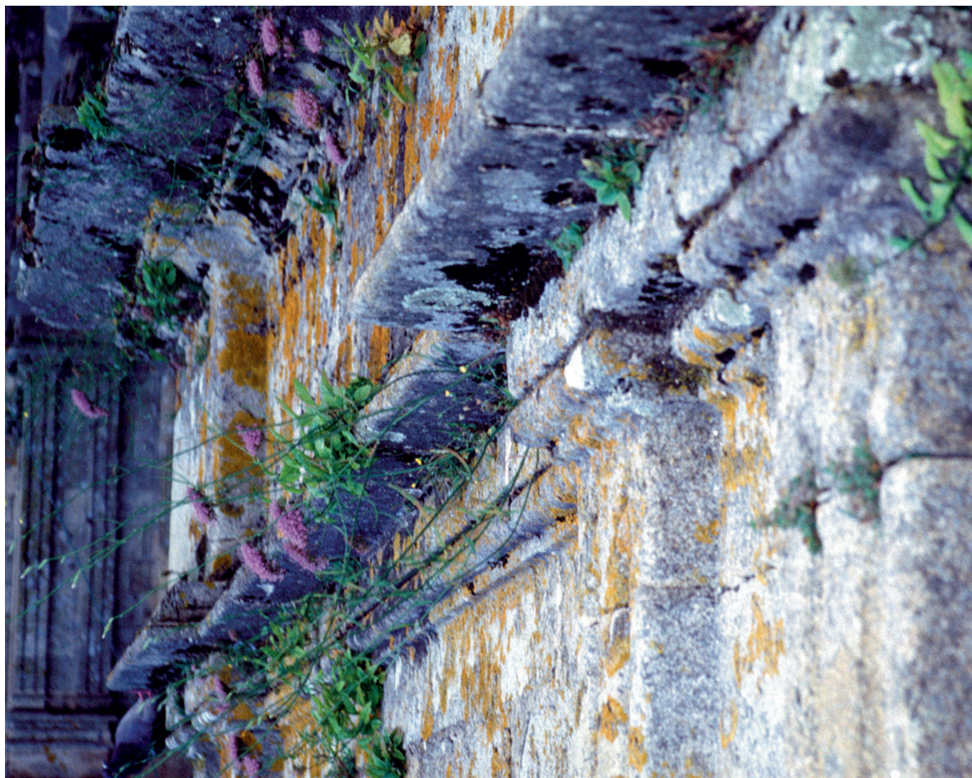
Fig. 11 – Le superfici dei monumenti in granito, se i tenori di inquinanti aereo dispersi sono bassi, vengono completamente colonizzate dai licheni, inclusi i sottosquadri: mancano patine da interazione e anche i biominerali, come viene spiegato nel testo, sono molto rari [Santiago de Compostela, Cattedrale di San Giacomo, particolare, Galizia, granito].
