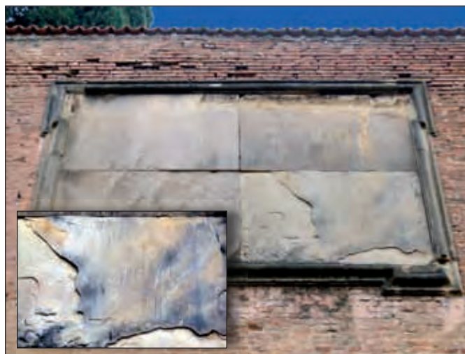
Figura 4 – La grande lapide collocata sul muro di cinta dell'antico convento di s. Maria degli Angeli, in via s. Caterina. Si vede chiaramente che essa è un collage di quattro lastre rettangolari in arenaria, identiche per dimensioni, circondate da una cornice, anch'essa in arenaria con modanatura, composta da 10 elementi. L'arenaria messa in opera con i piani di laminazione paralleli alla superficie esposta, si sta "squamando". Si può notare che il II quadrante, vale a dire quello in basso a destra [ingrandito in basso a sinistra], è il più degradato e quindi il più compromesso per quanto riguarda l'iscrizione.
