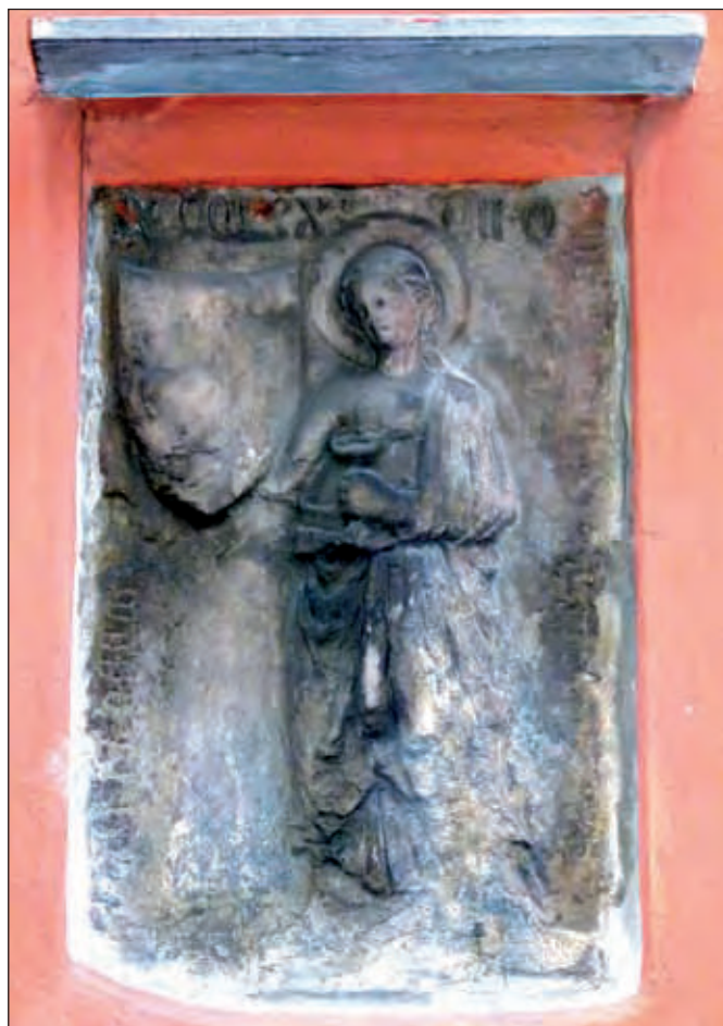
Figura 20 – La foto mostra lo stato del rilievo della s. Lucia oggi. Recentemente, ma tardivamente, l'immagine in arenaria è stata restaurata e protetta da un tettuccio in marmo che limita gli effetti dannosi dell'acqua ruscillante.
