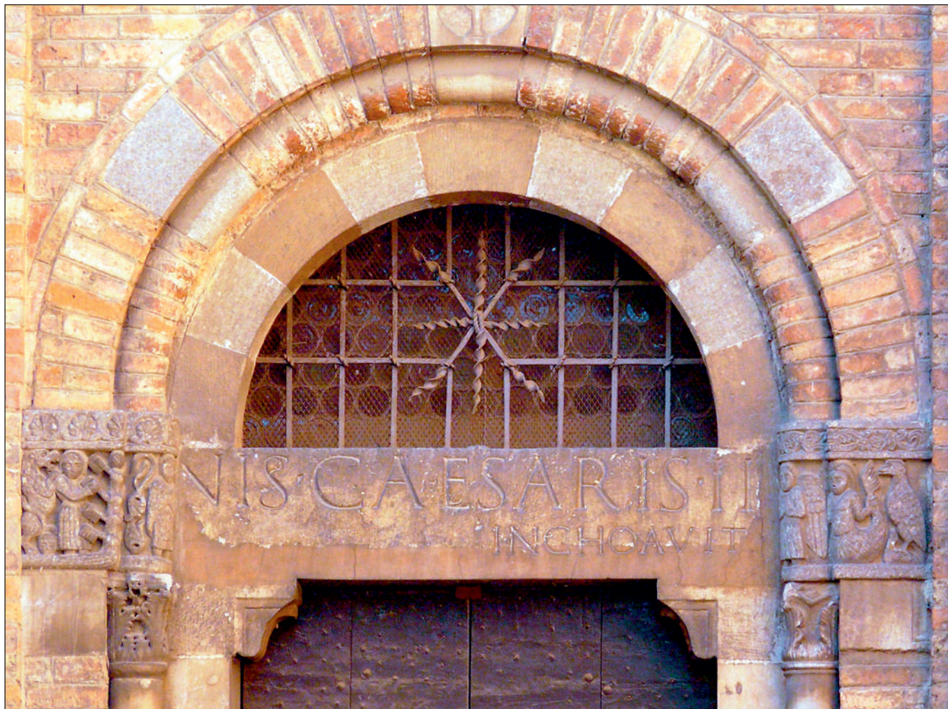
Fig. 1 – Complesso stefaniano, Basilica dei Ss. Vitale e Agricola, particolare della porta secondaria che guarda a ponente su via Gerusalemme. L'architrave in calcare micritico compatto porta incisa sul fronte una celebre iscrizione di età imperiale romana. Si tratta quindi di un elemento di spoglio che faceva un tempo parte di un importante monumento civile ai tempi di Claudio Nerone. Il lato di questa barra a sezione rettangolare che oggi guarda il cielo reca una seconda iscrizione che ricorda un restauro voluto dal cardinal Legato di Bologna Giuliano della Rovere che divenne poi Papa col nome di Giulio II. I tre archi concentrici sono dovuti alla fantasia di R. Faccioli [fine '800] e i due capitelli figurati in selenite vennero scolpiti ad hoc durante i restauri-rifacimenti del Gozzadini-Faccioli prendendo a modello quelli di S. Salvatore a Brescia. I due capitellini a forma di tulipano chiuso, non identici, in marmo, sono invece di spoglio e appartenevano a un monumento dell'VIII- IX secolo. La porta è quindi un patch-work realizzato utilizzando pietre diverse del I d.C., VIII-IX d.C., XV secolo e soprattutto XIX secolo.
