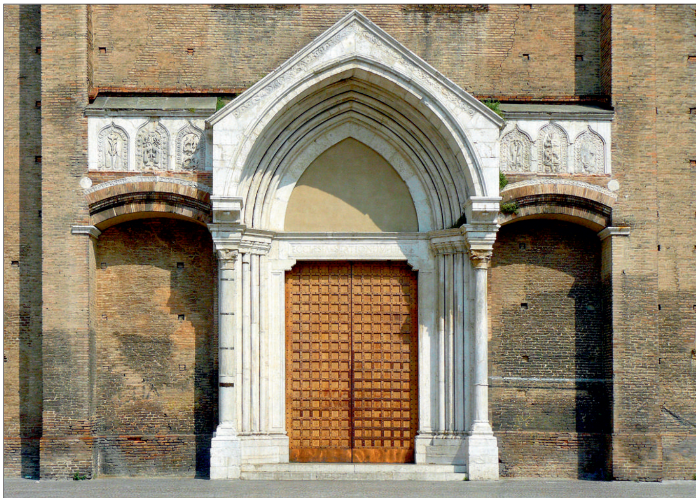
Fig. 6 a – Chiesa di S. Francesco: particolare del portale principale. L’opera che risale ai tempi della costruzione della chiesa [iniziata nel 1236, consacrata nel 1254 e del tutto compiuta qualche anno più tardi, nel 1263] venne realizzata con materiali di spoglio di varie epoche. Le due colonne più esterne, in cipollino greco [quella di sinistra ha tre fasce in metallo], sono scarnificate dal fuoco – quindi patirono in passato un grande incendio – provengono da una costruzione di età romana. I due capitelli che sovrastano queste colonne in pietra d’Istria appartenevano a un precedente edificio di culto cristiano dell’VIII-IX secolo. I sei rilievi figurati sono d’epoche diverse [v. t.] e dovevano far parte – a un certo punto della loro storia – di un pontile o di un ambone o più probabilmente di una recinzione presbiteriale. Le cornici [dette veneziane o gotiche o bizantine] di questi rilievi vennero realizzate in epoca successiva e dovrebbero risalire ai tempi della costruzione della chiesa, vale a dire al XIII secolo. In parte sono state restituite durante i restauri conseguenti ai danneggiamenti dovuti ai bombardamenti dell’ultima guerra: una data [1949, incisa in due punti] non lascia dubbi in proposito. Anche per il panneggio della cuspide triangolare vennero utilizzate pietre di risulta: i fantasmi di alcune lettere – in gran parte abrase – fanno pensare ad antiche pietre cimiteriali.
