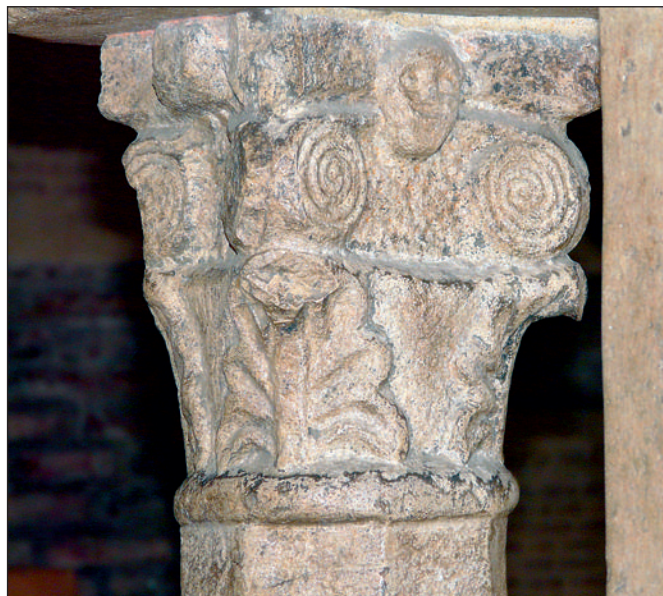
Fig. 4 – Complesso stefaniano, chiostro detto “dei Benedettini”: capitello in calcare compatto, sfuggito fortunatamente ai molti restauri, che esibisce interessantissime patine superficiali d'interazione ambientale. Fa parte di una delle quattro colonne abbinata [gruppo a sud] nel chiostro inferiore. Il monumento è caratterizzato da una singolare faccina umana che ride [in alto sulla destra], e doveva appartenere ad un edificio protoromanico o alto-medievale che si trovava in questo sito molto prima del 1000. Infatti tutti gli elementi [colonne, colonnine, capitelli] con cui venne realizzato il chiostro inferiore, verso l'anno mille, sono di spoglio da un monumento più antico. In particolare una seconda colonnina simile a questa, ma molto deteriorata, è presente nel secondo gruppo di quattro colonnine in opera subito a destra: l'appartenenza allo stesso monumento sembra più che evidente.
