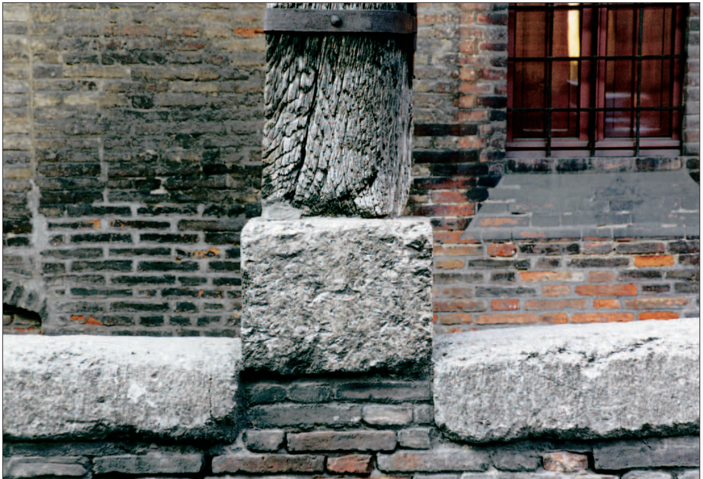
Fig. 10 – Sappiamo sia dalle fonti indirette sia da quelle dirette che la selenite ebbe largo impiego nelle costruzioni del XI-XIII secolo quale sistema di isolamento dalla risalita capillare dell'acqua dal terreno. Nelle poche case d'epoca che ci restano – tutte più volte rimaneggiate, talora anche pesantemente – si possono osservare blocchi di selenite interposti tra le colonne in legno e il suolo. La selenite veniva usata, forse con la stessa funzione, anche in strutture in cotto come è possibile osservare all'angolo tra vicolo Colombina e via Pignattari oppure in uno dei pilastri polilobati della cripta dei SS. Vitale e Agricola in Arena (questo però dell'VIII secolo). Questa pietra ha una bassa porosità, ma soprattutto ha i pori non comunicanti tra loro: la risalita capillare che porta al deperimento delle strutture sovrastanti, specie se in legno, è quindi o scarsa o nulla. Il particolare della foto si riferisce alla casa Boncompagni (oggi Palazzo Grassi) in via Marsala n. 12.
