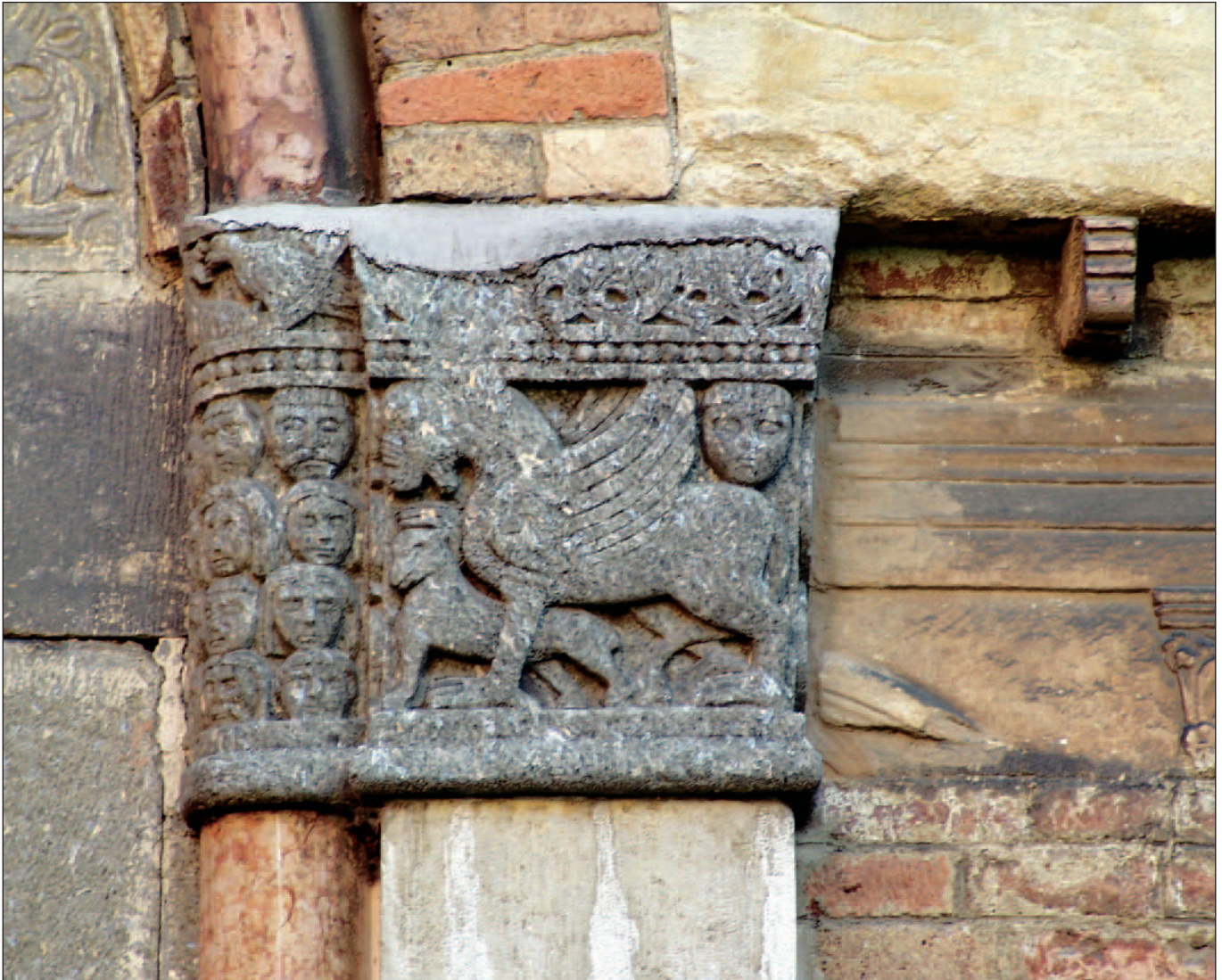
Fig. 14 – Capitello neo-romanico messo in opera sul montante destro del portale principale della chiesa dei SS. Vitale e Agricola (gruppo stefaniano). Per realizzarlo a fine '800 – assieme a quello simmetrico sulla sinistra e agli altri due sul portale laterale di via Santa – si presero a modello i capitelli romanici della Chiesa di San Michele a Pavia. Anche i quattro capitelli, sempre in selenite, presenti nella vicina chiesa del “Martyrium” detta “della Trinità” (sempre nel gruppo stefaniano) sono falso-romanici.
