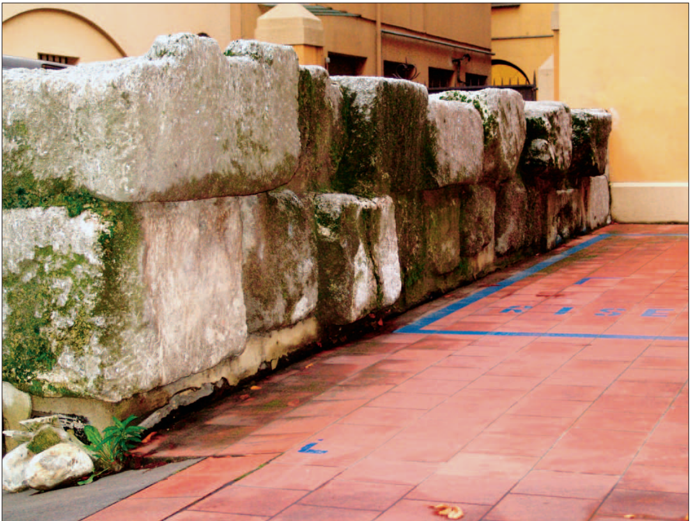
Fig. 4 – Questi massi ciclopici in selenite, provenienti dalle cave di Monte Donato, furono utilizzati come pietre di costruzione di un tempio romano, forse in legno e lastre in terracotta, situato in prossimità dell'attuale via Porta di Castello. Vennero poi reimpiegati, forse già alla fine del IV secolo, nelle mura di cinta della cittadella alto-medievale. I massi – forse di scavo, ma correttamente riposizionati - hanno direzione est-ovest e facevano quindi parte della muraglia settentrionale dell'oppidum. Si trovano tra le vie Porta di Castello e dell'Indipendenza.
