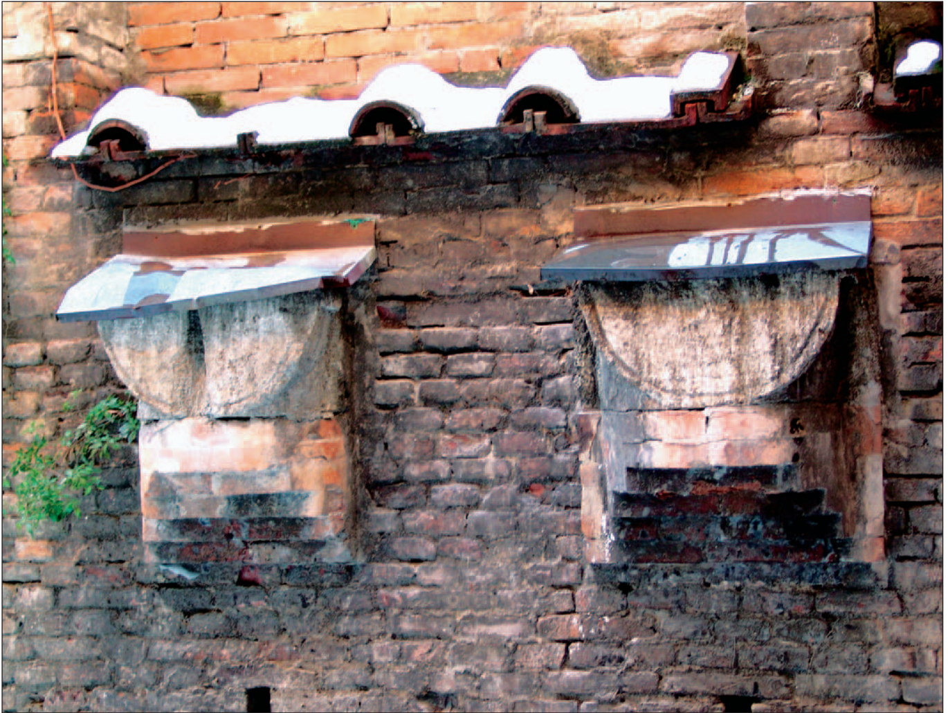
Fig. 5 – Capitelli a cubo smussato in selenite ritrovati durante uno scavo di fine '800 nel sito dei SS. Vitale e Agricola in Arena a circa 3 metri di profondità. Uno di questi capitelli è stato inserito nel muro subito a destra entrando nella cripta: gli altri sono stati affissi, protetti da un tettucio, sul muro che chiude a oriente il cortiletto dietro la cripta. Questi capitelli ornavano un tempo i pilastri polilobati in cotto dell'antica basilica tripartita dell'VIII secolo che qui sorgeva e di cui restano tracce cospicue. Sono tra i pochi reperti certi che documentano l'uso, a scopo ornamentale, di questa pietra nell'alto-medioevo a Bologna.
