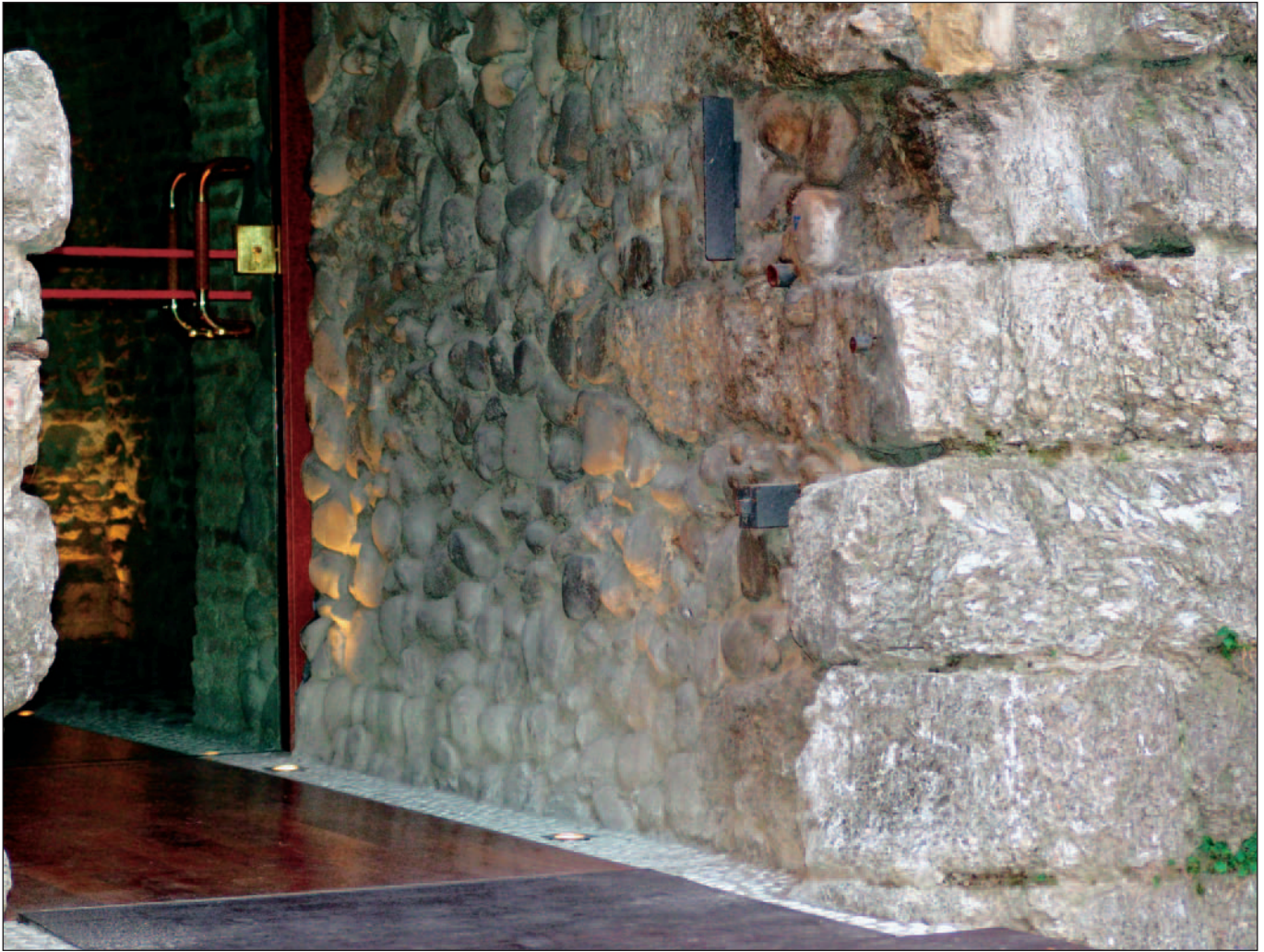
Fig. 9 – L'apertura - praticata qualche decennio fa - alla base della torre Galluzzi, sita nella corte omonima un tempo detta curia dei Galluzzi. Qui si può notare bene la costruzione a sacco. Una cortina esterna in grossi massi di selenite, il conglomerato in ciottoli rotondeggianti di fiume e calce, una seconda cortina interna ancora in blocchi di selenite, quest'ultima manomessa. Questa torre, anch'essa a pianta quadrata, ha i lati di 9.26 metri e uno spessore alla base di 3 metri: anche il vuoto interno è quindi di circa 3 metri. Il notevole spessore alla base fa pensare che la torre un tempo fosse molto più alta, almeno il doppio dell'altezza attuale o progettata per raggiungere tale altezza.
