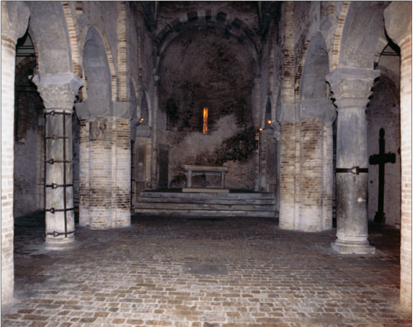
Fig. 12 - La selenite venne in passato utilizzata non solo sotto forma di conci per murature ma anche come pietra da taglio, in capitelli a fogliami e a cubo smussato, in monumenti del XI-XII secolo o anche, eccezionalmente, per veri e propri rilievi (Cfr. lastre del XII secolo nella Cattedrale di San Pietro). La foto si riferisce alla Chiesa dei SS. Vitale e Agricola (Santo Stefano) dove sono presenti, a corona di quattro pilastri cruciformi, capitelli cubici e, su tre delle quattro colonne, capitelli a fogliami. Questi ultimi sono però, probabilmente, falsi.
