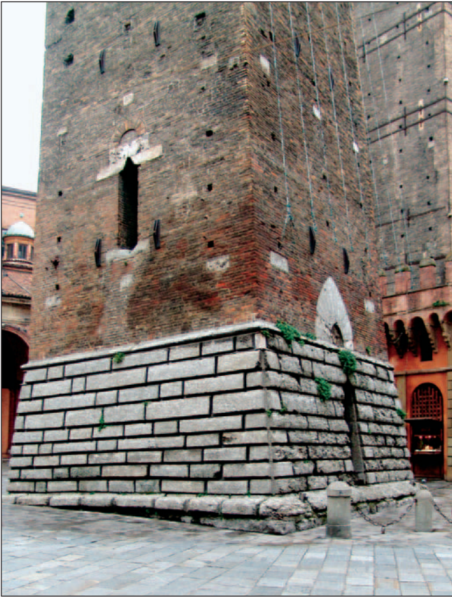
Fig. 8 – La torre Garisenda che si ritiene sia stata costruita verso il 1110 da Oddo Garisendi. E' oggi alta 47,50 metri, ma l'altezza doveva essere prossima ai 60 metri: quindi simile a quella delle torri Azzoguidi in via Altabella e alla Prendiparte in via Sant'Alò. A causa di un cedimento del sottosuolo la torre si inclinò, probabilmente, poco dopo la sua costruzione. Ai tempi di Giovanni da Oleggio, governatore di Bologna per conto dei Visconti (1350-1360), venne abbassata di circa 12 metri. La sua pendenza attuale è di circa 3,22 metri in direzione est-sud-est. Come le altre torri bolognesi rimaste ha pianta quadrata con i lati di circa 8 metri. La base è una costruzione a sacco realizzata con una doppia cortina di massi di selenite riempita da un conglomerato di ciottoli di fiume e calce: lo spessore del muro, alla base, è di 2,35 metri e si porta a 1,95 metri in cima. Il bugnato di selenite visibile sulla scarpata fu "incollato" ai blocchi originali portanti, anch'essi in selenite, durante un restauro avvenuto tra il 1887 e il 1889: le scanalature tra le lastre sono di pura invenzione e volte a migliorare l'estetica del monumento secondo il gusto dell'epoca: un tempo i massi erano rigorosamente a filo per impedire la scalata alla torre. Sopra la scarpata in selenite, coronata da un toro sempre in selenite, i lati della torre si riducono a circa 7 metri. Da qui in poi la torre procede, sempre con struttura a sacco, in cotto. La porta architravata in selenite, sul lato di ponente, non è coeva alla torre, ma fu aggiunta in un momento successivo. Le torri fino a che svolsero la loro funzione offensiva-difensiva non ebbero porte, ma piccole porte-finestre. L'ingresso originario alla torre è qui visibile sul prospetto nord a circa 6 metri d'altezza: la porta-finestra ha architrave e soglia – molto consumata – in selenite. La "luce" dell'architrave è spezzata da due mensole stondate, sempre in selenite, dette modiglioni. Il peso della struttura muraria sovrastante viene scaricato lateralmente tramite un piccolo arco a tutto sesto. Osservando i prospetti a nord e a ovest sono visibili a distanze regolari i covili o fori da ponte utilizzati al momento della costruzione e per i successivi restauri e i meniani. Questi erano barre in selenite – oggi quasi completamente disciolti – che sporgevano verso l'esterno e avevano la funzione di sorreggere i ballatoi in legno che coronavano la torre a varie altezze. Tre di queste strutture sono visibili subito sotto la porta-finestra – e altri due, alla stessa altezza sul prospetto ovest – dove un tempo v'era il primo ballatoio. Altri sei, tre sul prospetto nord e tre su quello ovest tutti rigorosamente alla stessa altezza, spiccano più in alto, in corrispondenza del secondo ballatoio. Le sedi di altri quattro ballatoi, qui non visibili, si trovavano, regolarmente distanziati, sopra questi primi due.
