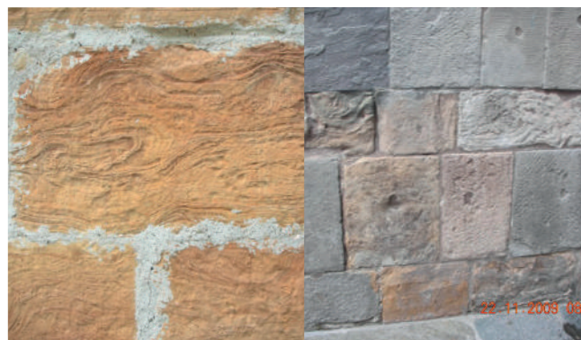
Fig. 9 – Conci con laminazioni convolute Torre S. Prospero
