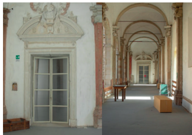
Fig. 17b – I corridoi e i locali interni
