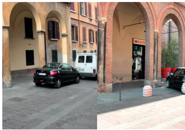
Fig. 10 - Colonne in via S. Carlo
