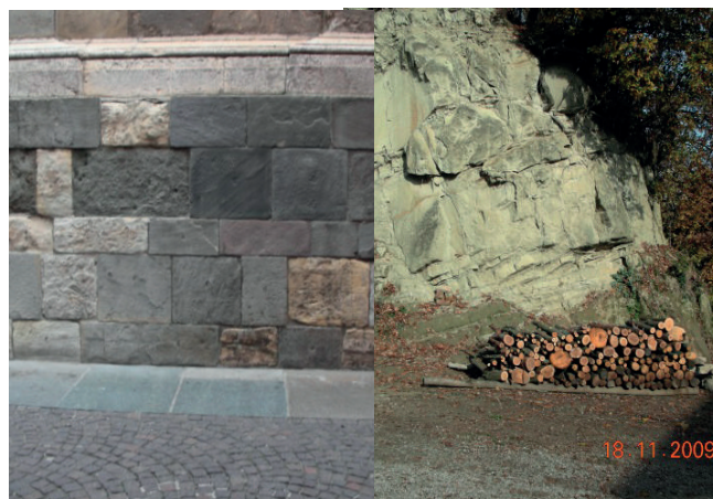
Fig. 11 – Arenarie litiche di Paderna presenti nella Torre di S. Prospero
