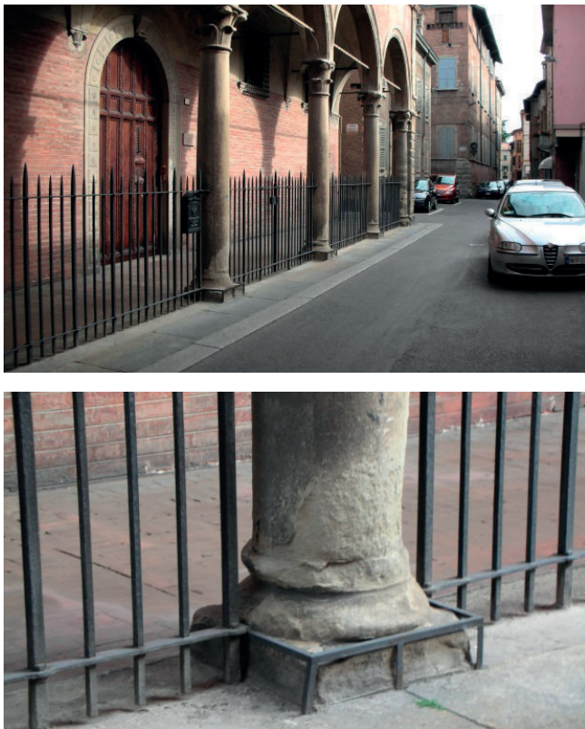
Fig. 3 - Le colonne di Palazzo Boiardi (seconda metà del 1400) che " calcaree, con matrice argilloso-marnosa, facilmente lavorabili, impiegate solo parzialmente, come elemento ornamentale o di sostegno, in fabbricati fatti prevalentemente di mattoni. Citiamo fra tutti il Palazzo dei Mercanti o dell'Arte del Panno, con le Arti della lana e della seta, situato in via San Carlo, corredato da un pilastro con cornucopie e teste di ovino, a significare che lì si lavava nel canale di Secchia e poi si tesseva la lana, e, dice la storia, anche la seta. Il palazzo fu iniziato nella seconda metà del '400 e finito nel 1541 (Fig. 2).
