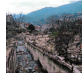
27 - Canalizzazione del rio Figu Nieddu, il canale è stato letteralmente "acoperchiato" durante la dicembre 2004. Si apprezza il materiale solido trasportato lungo i versanti.
