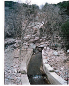
26 - Opera di canalizzazione nel rio Bas Porcos all'ingresso dell'abitato.
